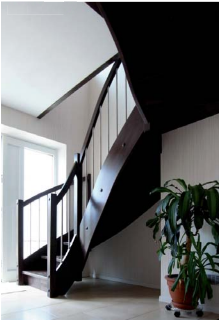
Wangentreppe mit Tritt- und Setzstufen
