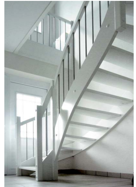
Wangentreppe mit eingestemten Stufen
