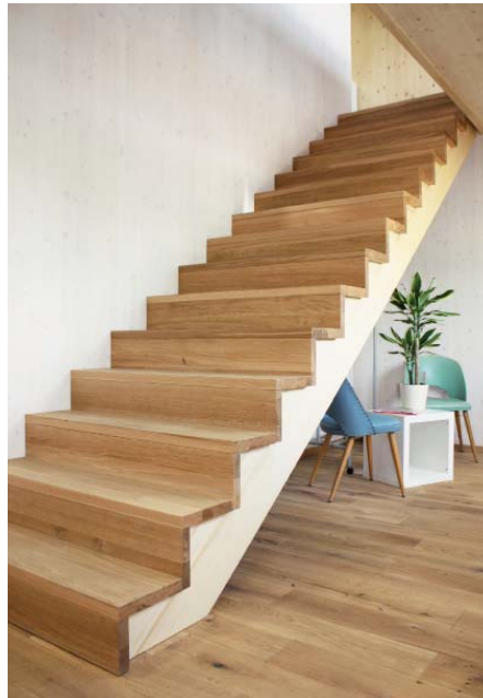
aufgesattelte Tritt- und Setzstufen, Eiche geölt
